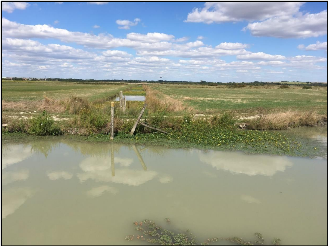
Figure 7 : canal perpendiculaire au tronçon gen 11 - 01/09/20
