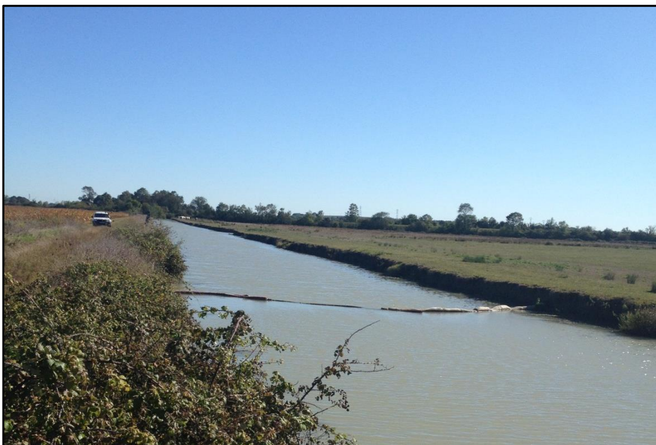
Figure 2 : Barrage flottant sur le canal de Rochefort
